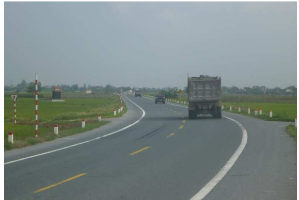
【写真④】 通行状況（新設バイパス）
