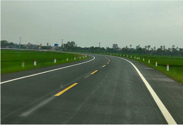
【写真①】 新設バイパス部
