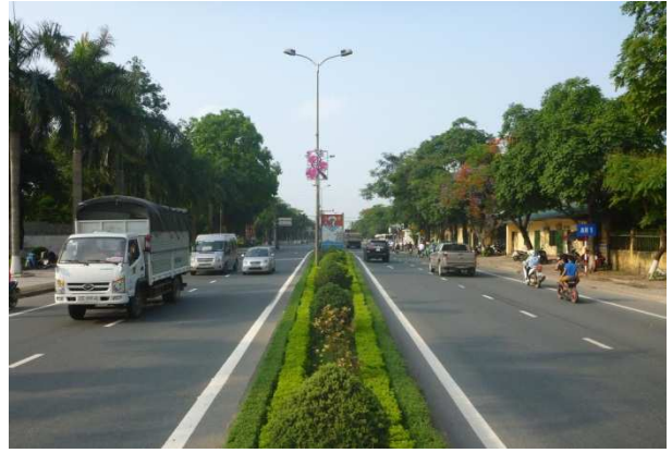
【写真②】 既設国道改良部
